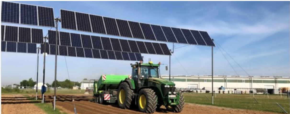
Pilotanlage mit abgespannter Seilaufhängung in Straßkirchen, Bayern (Krinner Carport GmbH, Harlander)
