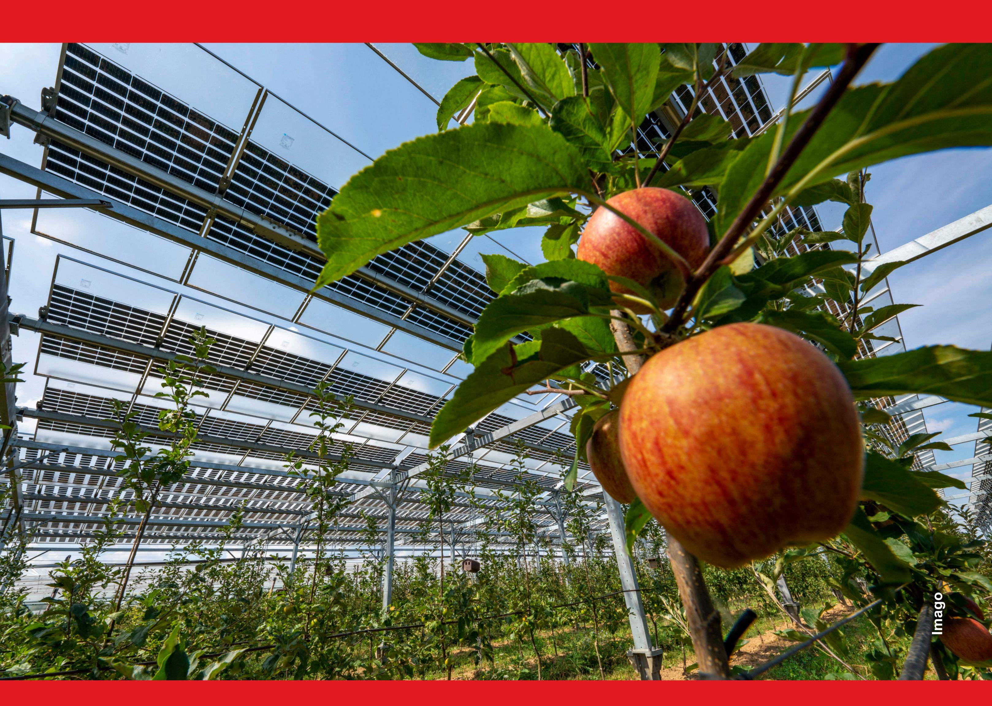
Die Module reduzieren Winderosion und Verdunstung, schützen die Pflanzen so vor Austrocknung. Schatten liebenden Pflanzen bieten sie Sonnenschutz. Zudem ersetzen die Solardächer herkömmliche Hagelnetze oder Folientunnel, reduzieren somit den Plastikabfall und wegen des günstigeren Mikroklimas zugleich den Einsatz von umweltschädlichen Pflanzenbehandlungsmitteln. Und der Wind im Küstenland Schleswig-Holstein? Hersteller garantieren Standfestigkeiten von 150 Kmh!
