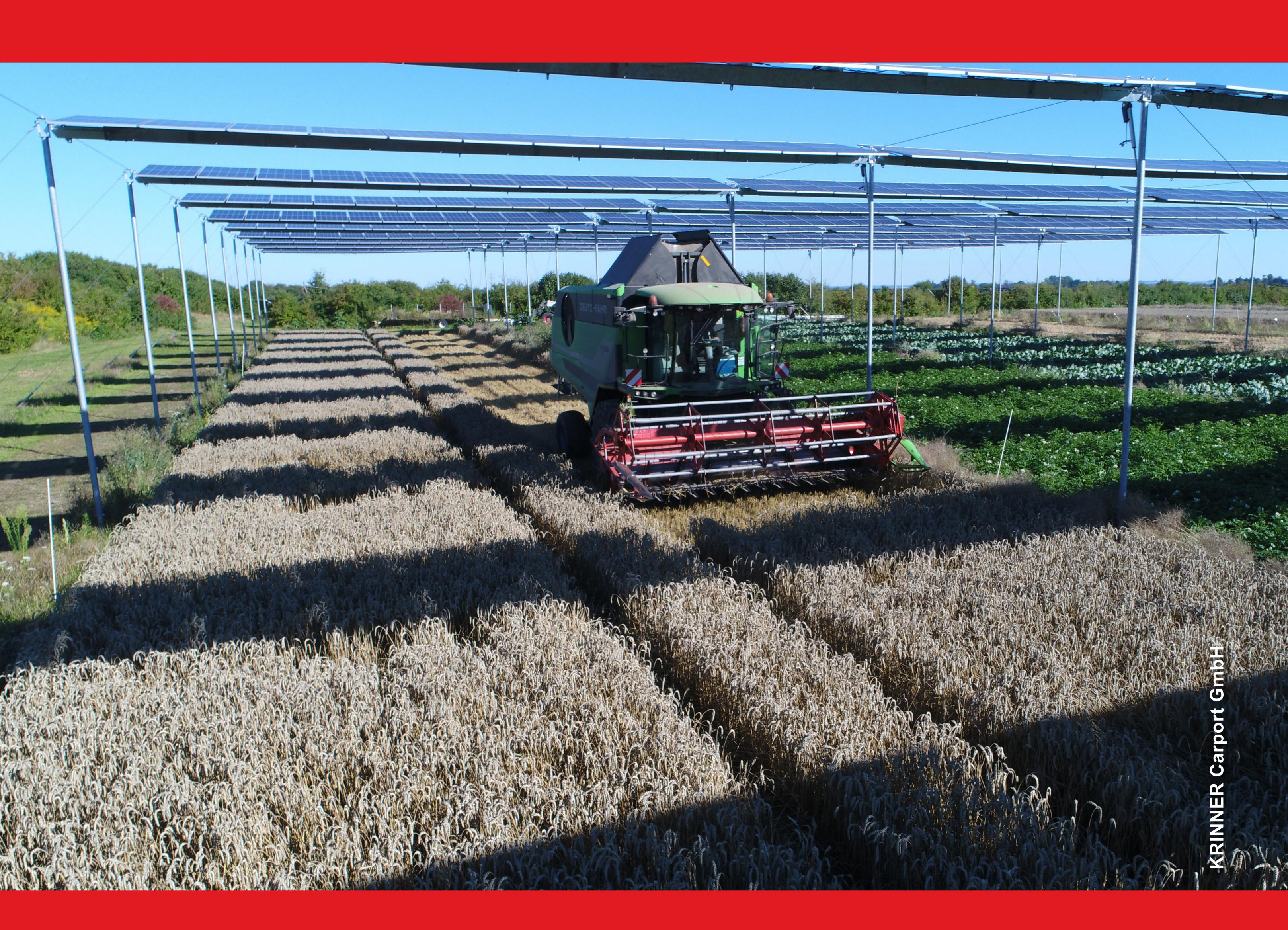
Die Module werden aufgeständert oder bodennah installiert. Anlagenhöhe und Reihenabstände lassen sich an Arbeitsbreiten, Licht und Wasserbedürfnisse der Kulturpflanzen oder der gehaltenen Tiere anpassen. Auf nur vier Prozent der deutschen Agrarfläche ließen sich 500 Terawattstunden Strom erzeugen, was dem heutigen Bedarf Deutschlands entspräche. Agrargas-Mais benötigt 40 mal mehr Fläche für die gleiche zu erzeugende Strommenge.
