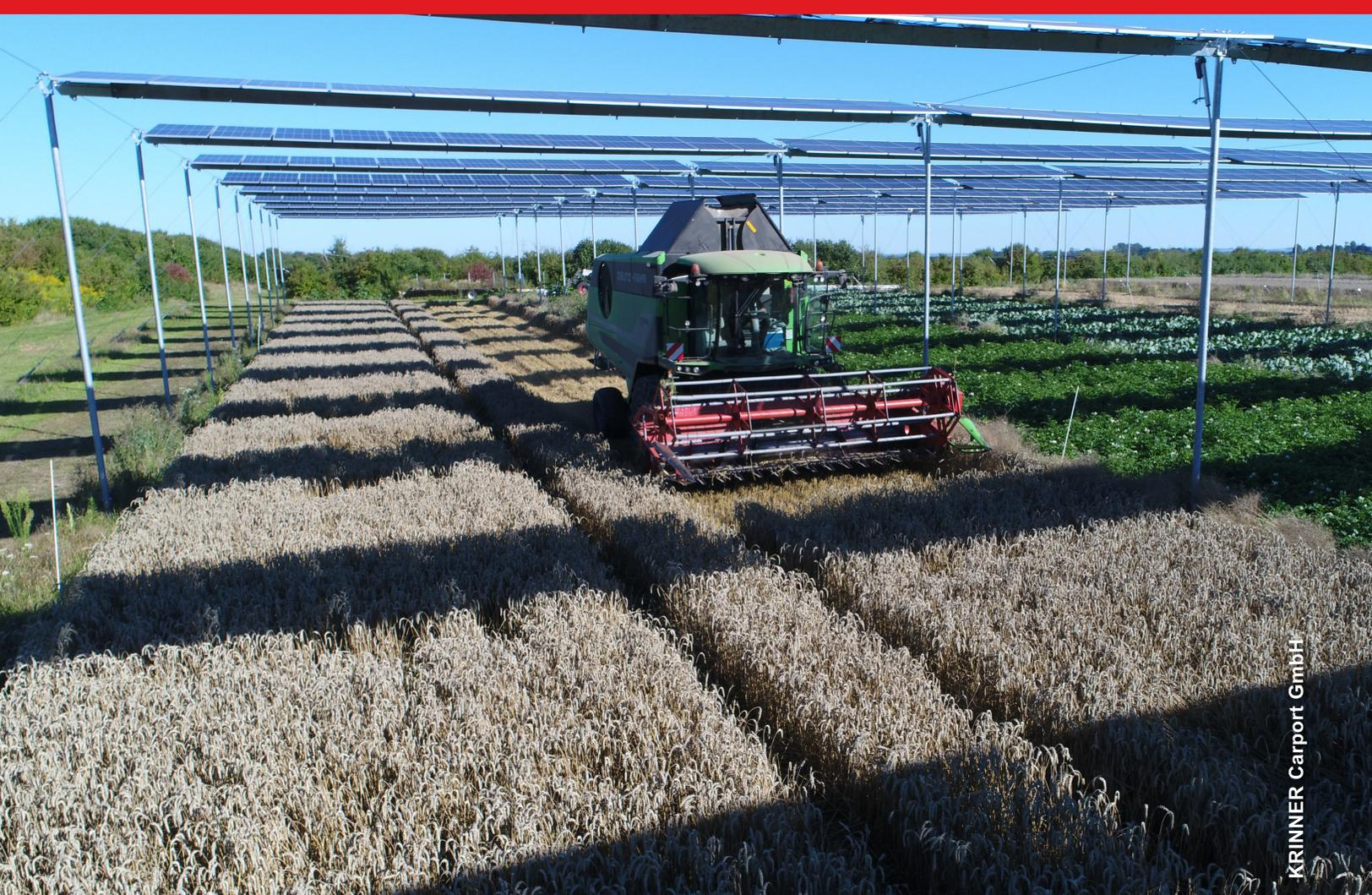
Die Module werden aufgeständert oder bodennah installiert. Anlagenhöhe und Reihenabstände lassen sich an Arbeitsbreiten, Licht und Wasserbedürfnisse der Kulturpflanzen oder der gehaltenen Tiere anpassen. Auf nur vier Prozent der deutschen Agrarfläche ließen sich 500 Terawattstunden Strom erzeugen, was dem heutigen Bedarf Deutschlands entspräche. Agrargas-Mais benötigt 40 mal mehr Fläche für die gleiche zu erzeugende Strommenge.
